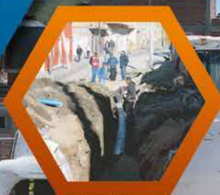
RENOVACIÓN DE LA RED
