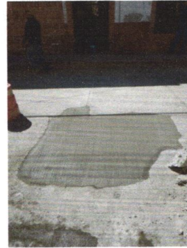
Reparación de rotura
