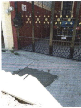
Ave. Los Arcos #44
