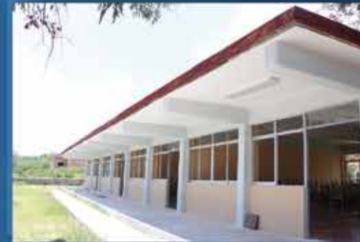
Rehabilitación escuela de San Pedro
