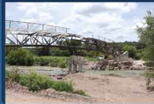
Puente en El Gavilán
