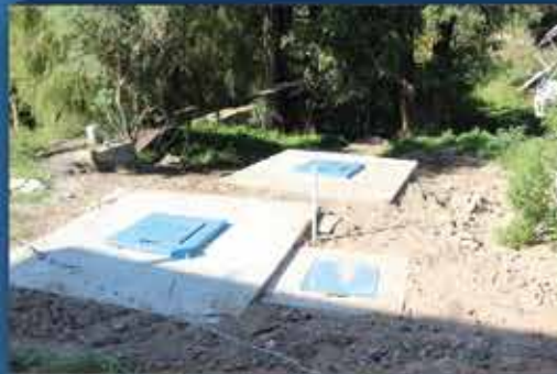
Drenaje Ajojúcar Etapa 2
