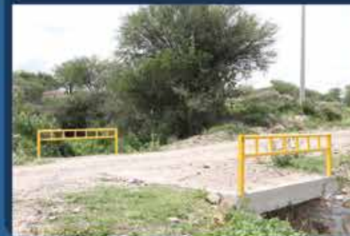
Rehabilitación puente Mazcuca / Analco
