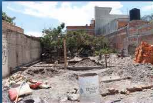
Construcción vivienda en San Pedro
