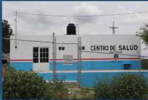
Ampliación red eléctrica Ostotán
